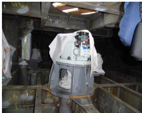
図2 設置中の舵取機
