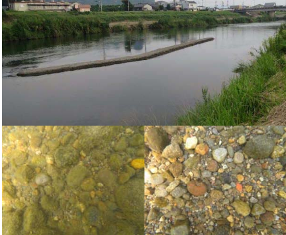
写真2 造成した産卵場(St.4)(上) 造成場の河床(左下:造成前,右下:造成後)
