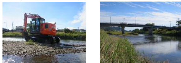
図2 造成の様子(左:重機での造成 右:造成後)
