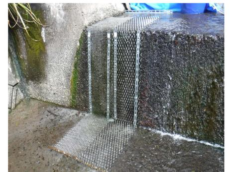
マルチフラットバーで金網の上端, 下端, 壁面を固定
