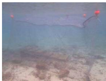
図3 ポリエチレンネット設置状況 (階段状藻礁)
