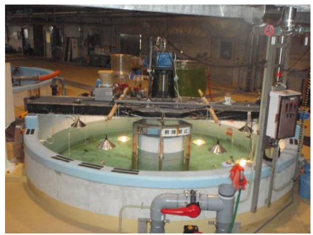
写真5 アルミア孵化槽から20 t 水槽へ(移槽後) ※ ワムシ餌付け後, 20 t 水槽へサイホンで移槽 ※ 100W×6基の白熱球(ペンダントライト)を設置。
