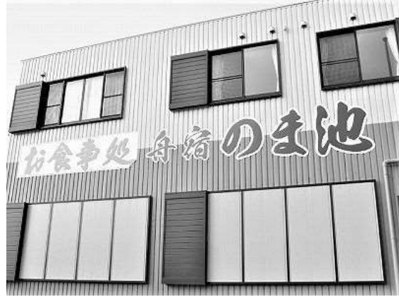
図11 食堂へ改装後の「舟宿 のま池」
