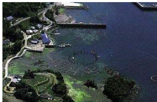
平成元年：長島町茅屋漁港
