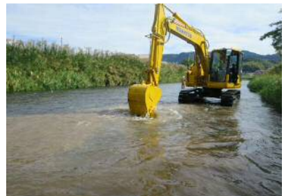
図3 造成作業の状況
