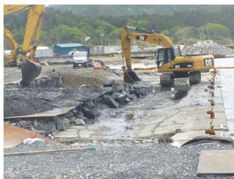
復旧工事中の漁港
