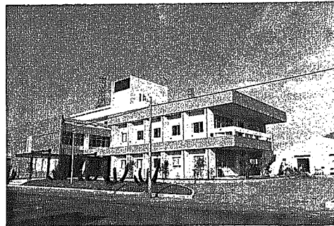
新庁舎の全景
