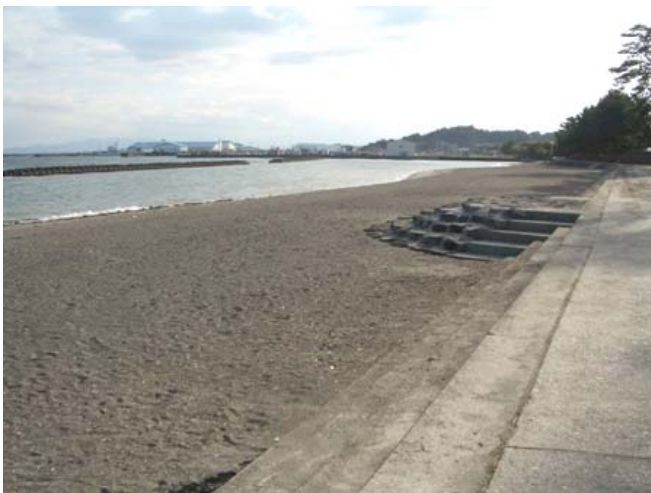
完成した砂浜（向かいは、今和泉漁港） 当センターも写っています。（ブルーの屋根）
