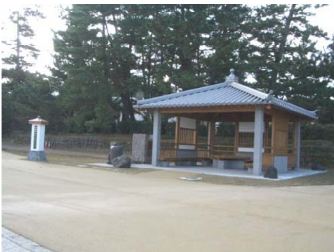
完成した無料休憩所
