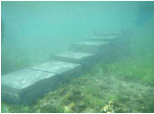
図2 H27. 3. 27 設置した階段状藻礁
