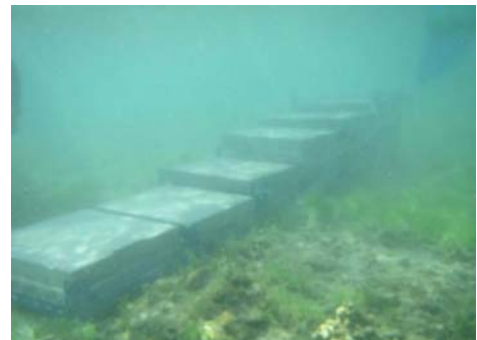
図8 H27.3.27 設置した階段状藻礁
