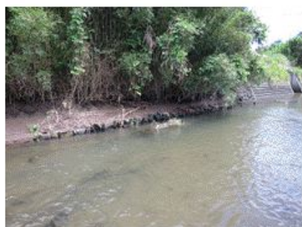
写真12 左岸木杭護岸
