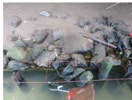
写真13 左岸木杭護岸
