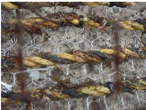
図5 カゴ内に設置した繊維状根付きロープ
