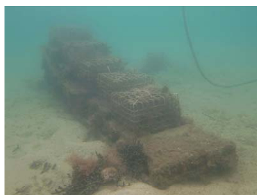
図4 カゴを設置した階段藻礁(岸側)
