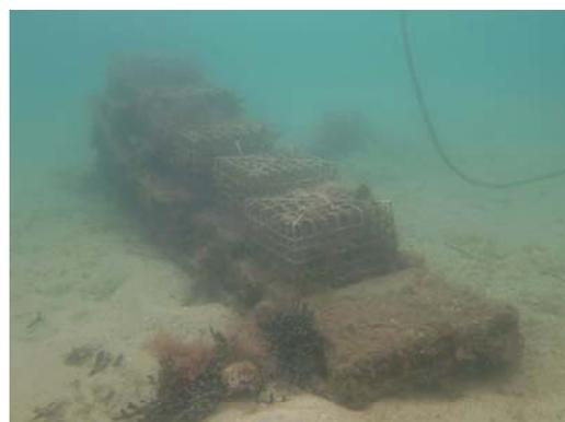
図4 カゴを設置した階段藻礁(岸側)
