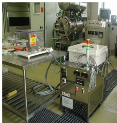
写真1 通電加熱電源装置
