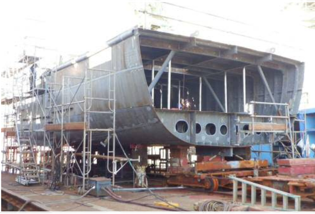
図1 船殻ブロック組み立て状況（船底）
