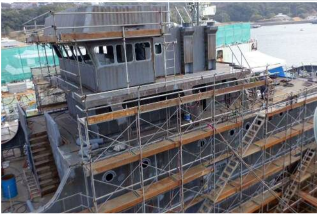
図3 上部構造物施工状況（船橋）
