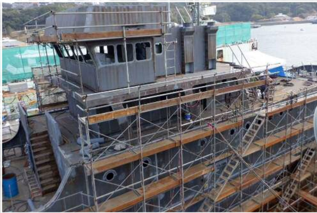
図3 上部構造物施工状況（船橋）
