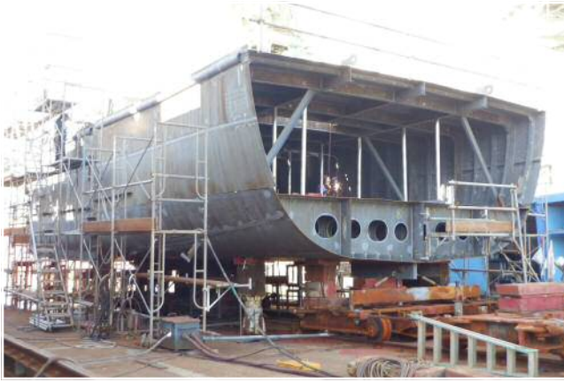
図1 船殻ブロック組み立て状況（船底）
