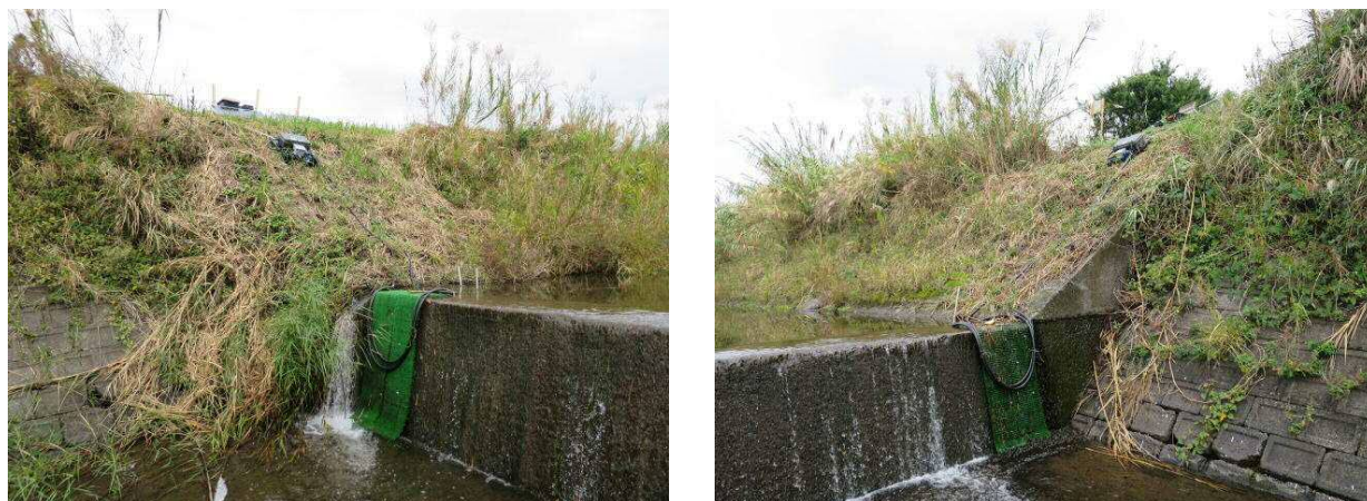
図2 芝マット魚道とPITタグアンテナシステムの設置状況
