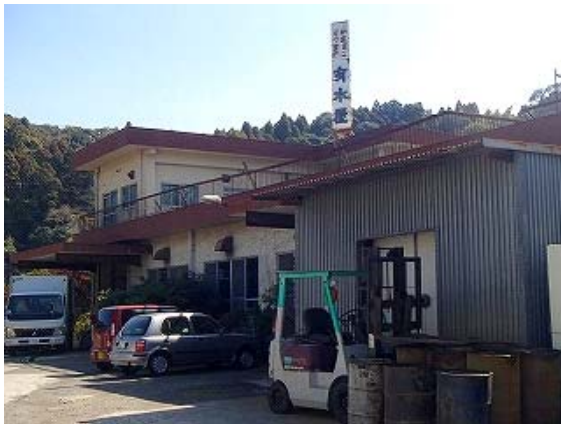
加工調査を実施した有水屋
