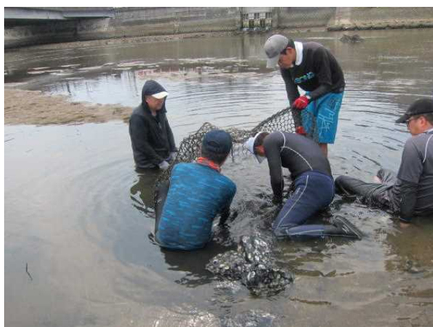
図3: 埋没した下流石倉の掘り起こし作業
