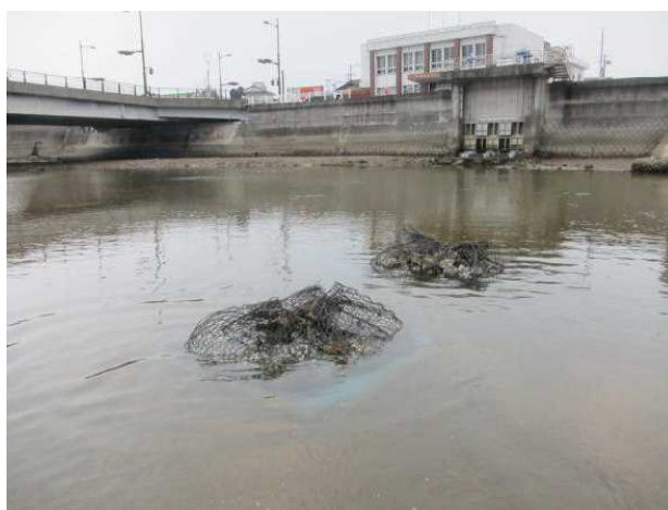
図4: 下流の石倉設置完了
