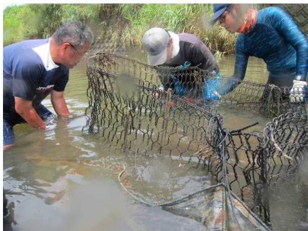
図1: 上流石倉設置作業風景
