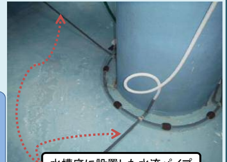
水槽底に設置した水流パイプ
