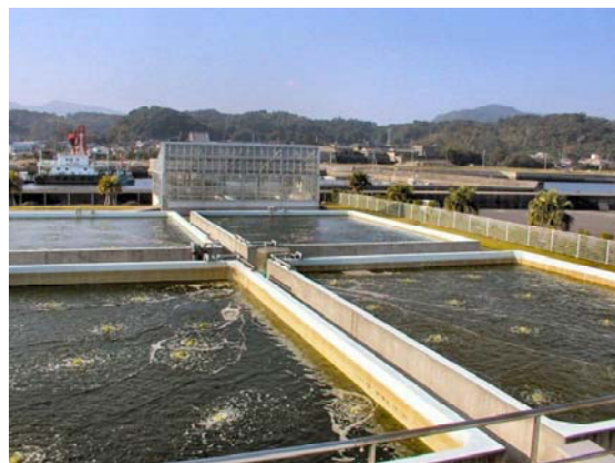
ナンノクロロプシス培養水槽 (140トン水槽 4面)
